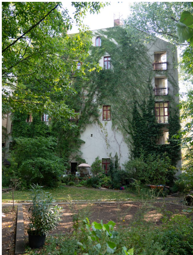
Abb. 8: Ansicht Brandwand Fraenkelufer 8 (C4C)
