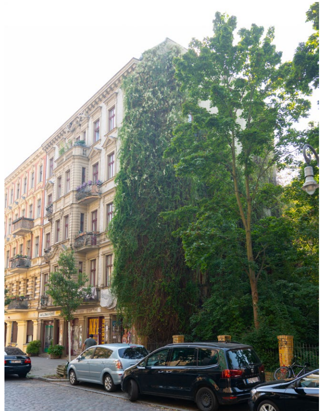
Abb. 6: Ansicht Wohnhaus Kohlfurter Straße 40 mit begrünter Brandwand (C4C)
