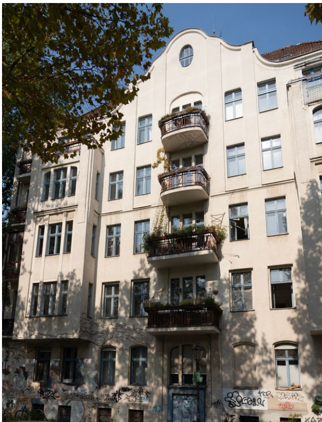
Abb. 7: Ansicht Wohnhaus Fraenkelufer 8 (C4C)
