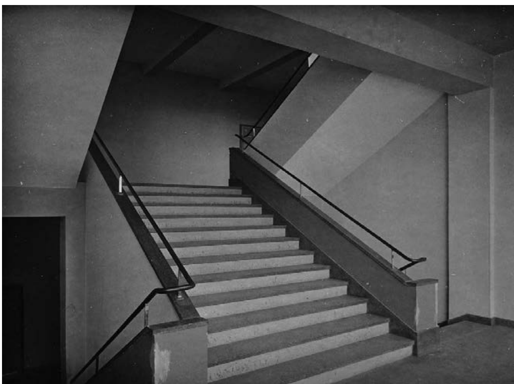
Bauhausgebäude Dessau, Treppenhaus der technischen Lehranstalt, um 1927 Bauhaus Building Dessau, stair cases pf the engineering school, around 1927
