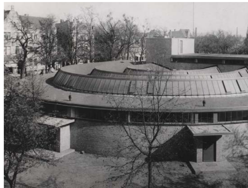
Hist. Arbeitsamt Dessau, Architekt Walter Gropius, 1927-29 / Hist. Employ
